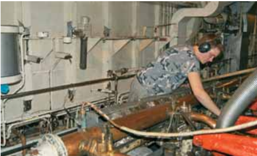
LEKKASJE. Det har blitt lekkasje i brennstoffventilen, og elev Rolf Arne Lakseide må være med å reparere før avreise til Göteborg.
