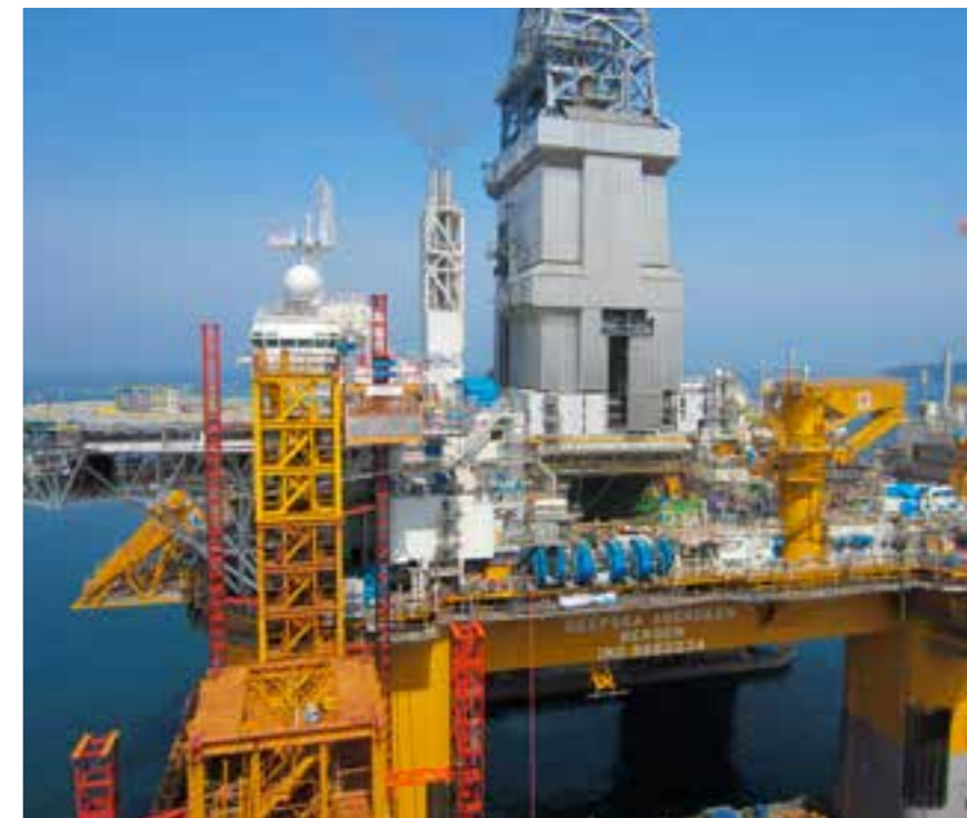
STOR VEKST I FARTØY OFFSHORE: Her er Deepsea Aberdeen under bygging på DSME i Sør-Korea. FOTO: SVEINUNG IVERSEN
