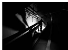
Håvard Melvær - Tankinspeksjon.jpg
