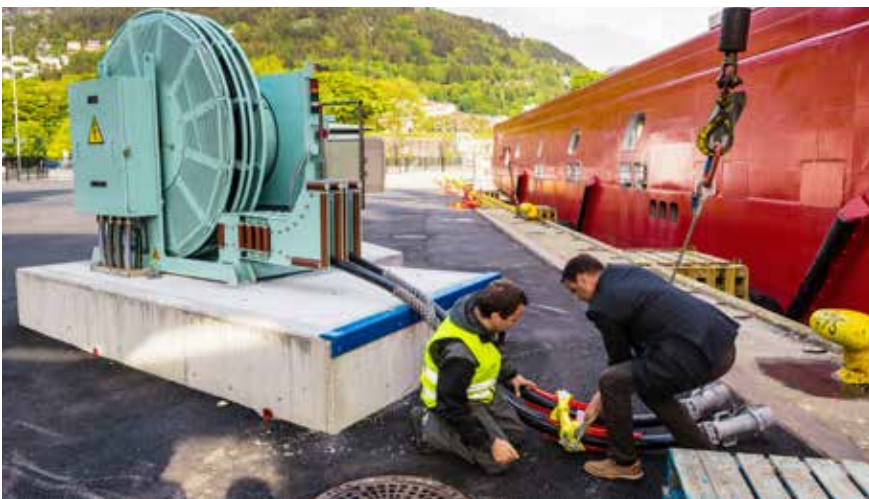
TUNGT: Her er leidningane som skal løftast opp til Skandi Vega med krane.
