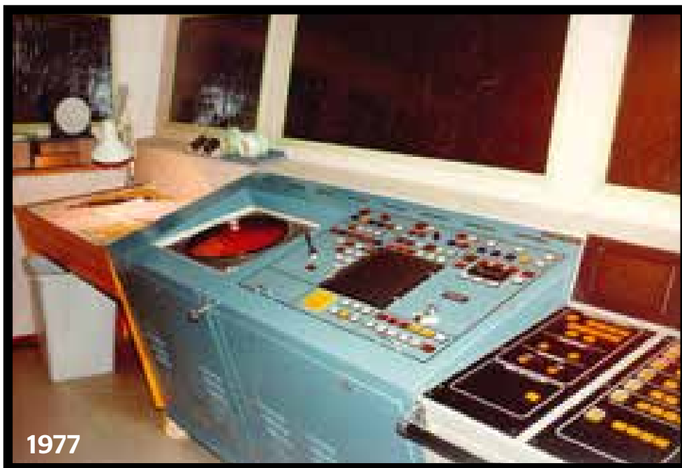
1977: Den første generasjonen Radar/ARPA-simulator, her fotografert i Horten i 1977. Fem norske maritime skoler hadde slike. Dette var simulering på faktisk broustyr, dvs. Data-Bridge 2. Utenfor vinduene var det et komplett anlegg for å spyle vann på rutene, for å skape et levende inntrykk av seiling i under vanskelige værforhold. FOTO: KONGSBERG MARITIME
