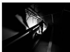
Håvard Melvær - Tankinspeksjon.jpg
